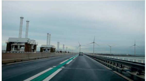
Foto 4: N57 op de Oosterscheldekering. Aan de rechterzijde is de relatief lage leuning te zien
