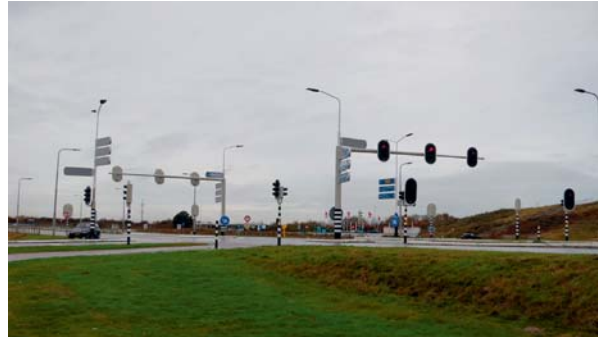
Foto 2: Kruispunt Breezand gezien vanuit zuidoostelijke richting
