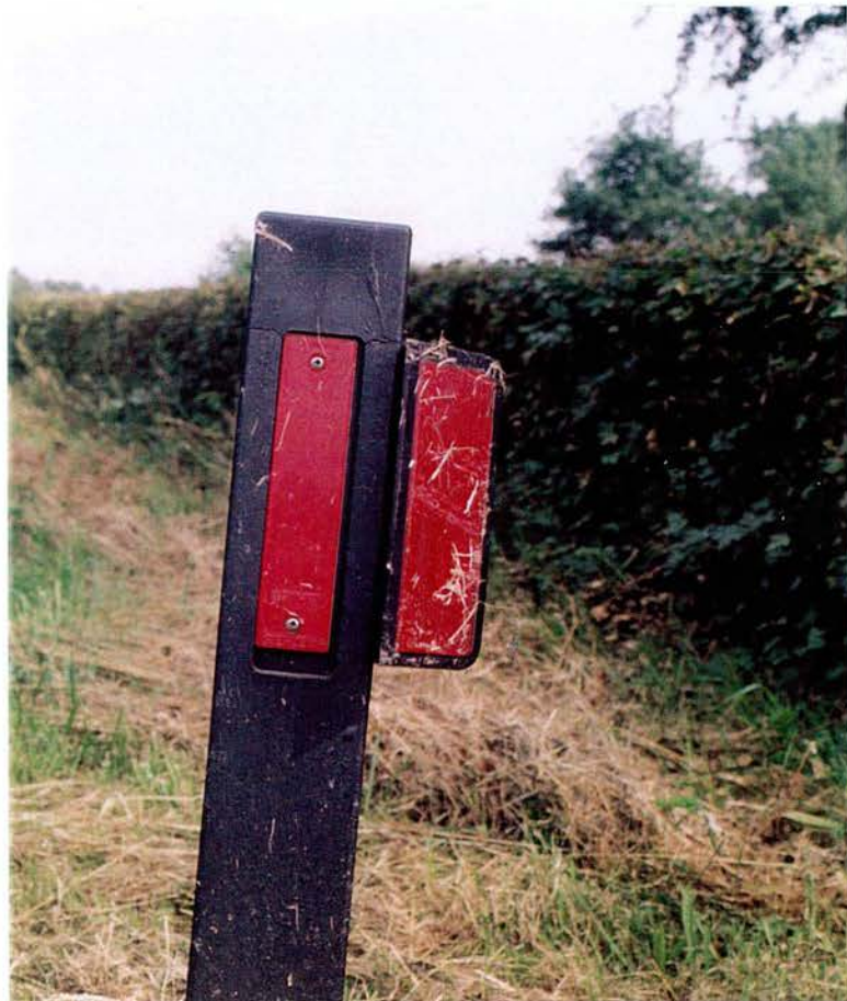
Slecht onderhouden vervuilde en scheef staande wildreflector aan de verkeerde kant van het paaltje en vlak voor een dichte heg (foto J.G. de Molenaar).
