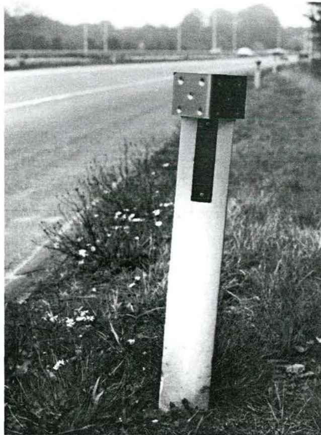
Wildspiegels langs autosnelwegen kunnen in de berm ook zo worden opgesteld dat het weerkaatste licht zowel over de weg als direct naar de omgeving schijnt (foto D.A. Jonkers).
