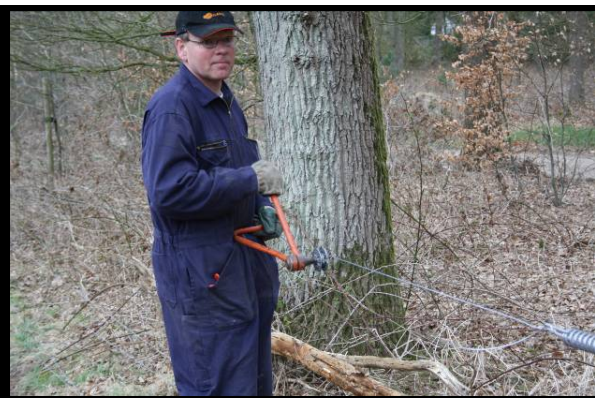
Figuur 5: het inspannen van de draad door een technicus van Gallagher.
