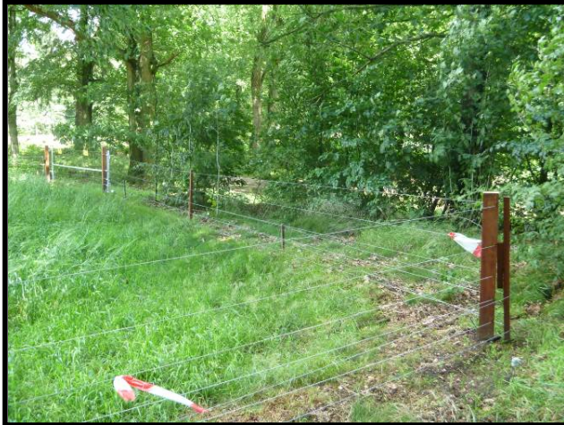
Figuur 6: de afrastering met een voordraad.
