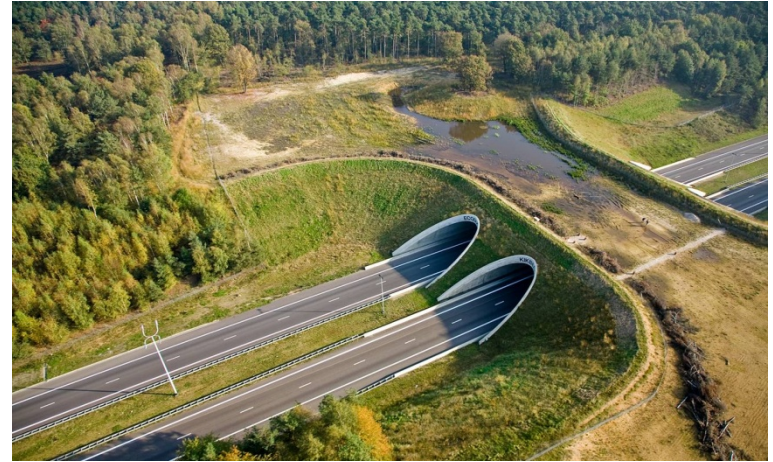
Ecoduct Kikbeek E314
