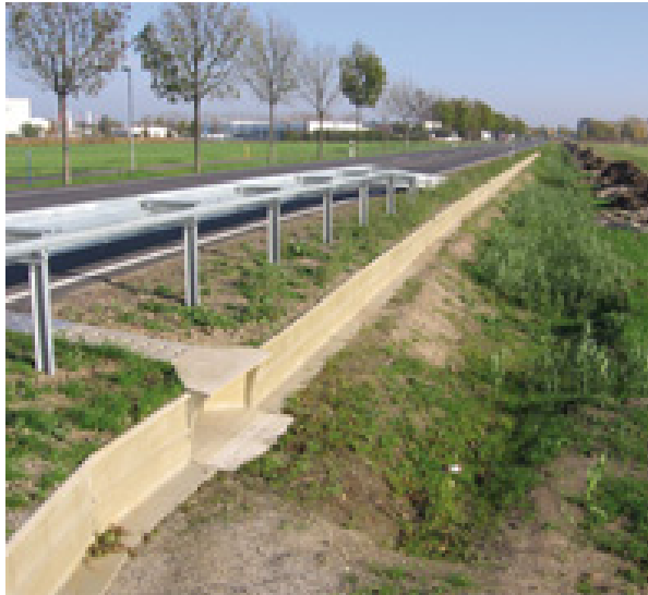
Amfibieëntunnel met geleidingswanden (polyesterbeton)
