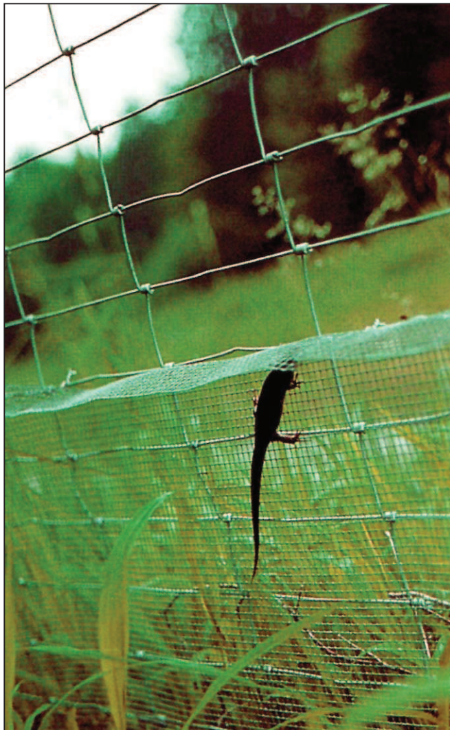
Abb. 13: Doppelzaun für Großsäuger und Amphibien. Der weitmaschige Zaun allein reicht nicht aus um Amphibien zurückzuhalten. Das zusätzliche Anbringen eines niedrigen engmaschigen Zaunes mit Übersteigschutz hindert auch Kleintiere am Durchschlüpfen.
