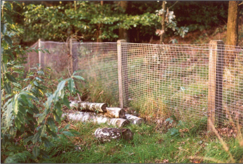
Abb. 12: Dachszaun an der zuvor beschriebenen Stelle. Die Zäune waren zunächst nicht tief genug eingegraben, so dass die Dachse sie stellenweise untergruben und dennoch auf die Eisenbahntrasse liefen. Erst eine tieferes Einsenken des Zaunes stoppte die Unfälle endgültig.
