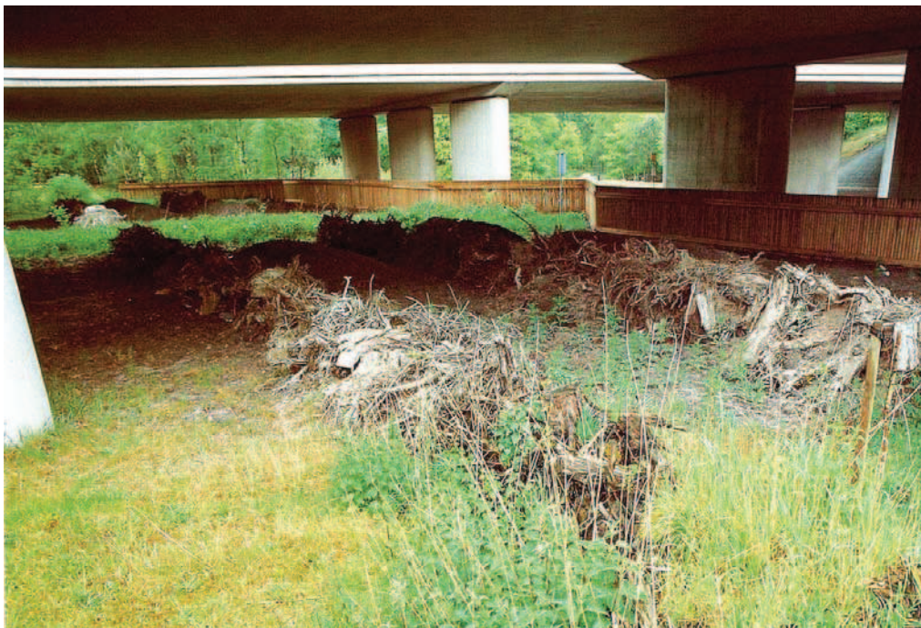
Abb. 3: Aufständierung mit Anlage von Wanderstrukturen bei einer Autobahn in den Niederlanden
