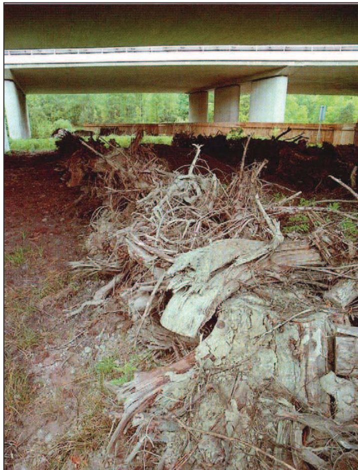
Abb. 9: An dieser Stelle ermöglicht die Aufständerung der Autobahn prinzipiell eine Passage von Tieren.
