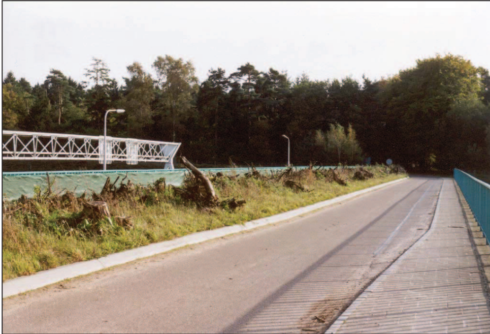
Abb. 10: Diese wenig befahrene Brücke quert die Autobahn. Sie wurde jedoch nicht von Tieren als Passage genutzt, da sie keine Deckung bot. Durch das Anlegen eines Grasstreifens mit Stubben wurde das Strukturangebot so verbessert, dass nun Kleintiere passieren können.
