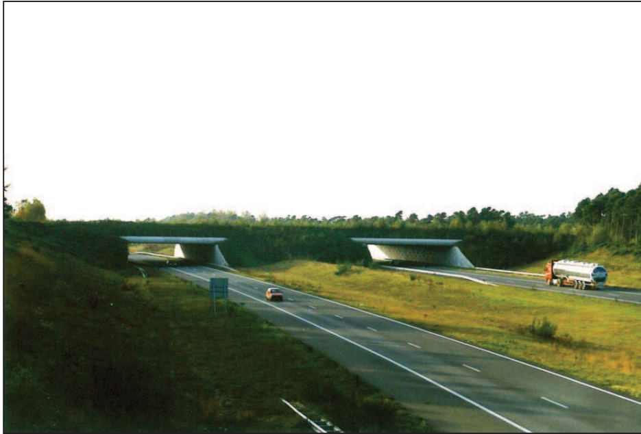
Abb. 6: Grünbrücke an der A1 in den Niederlanden. Die Brücke hat eine Länge von 80 m, eine Breite von 15 m an ihrer schmalsten Stelle in der Mitte und von 30 m an den Seiten.
