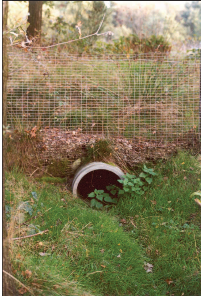
Abb. 11: Dachstunnel unter einer Eisenbahnlinie in den Niederlanden. An dieser, im Zentrum einer Dachspopulation gelegenen Eisenbahntrasse kam es zu häufigen Unfällen, ebenso wie an der direkt dahinter parallel verlaufenden Straße. Die vielen Verkehrstopfer schwächten die Population empfindlich, so dass ihr Aussterben befürchtet wurde. Seit der Installation einer Sperreinrichtung an Straße und Eisenbahn mit entsprechenden Passagen, erholte die Population sich wieder.
