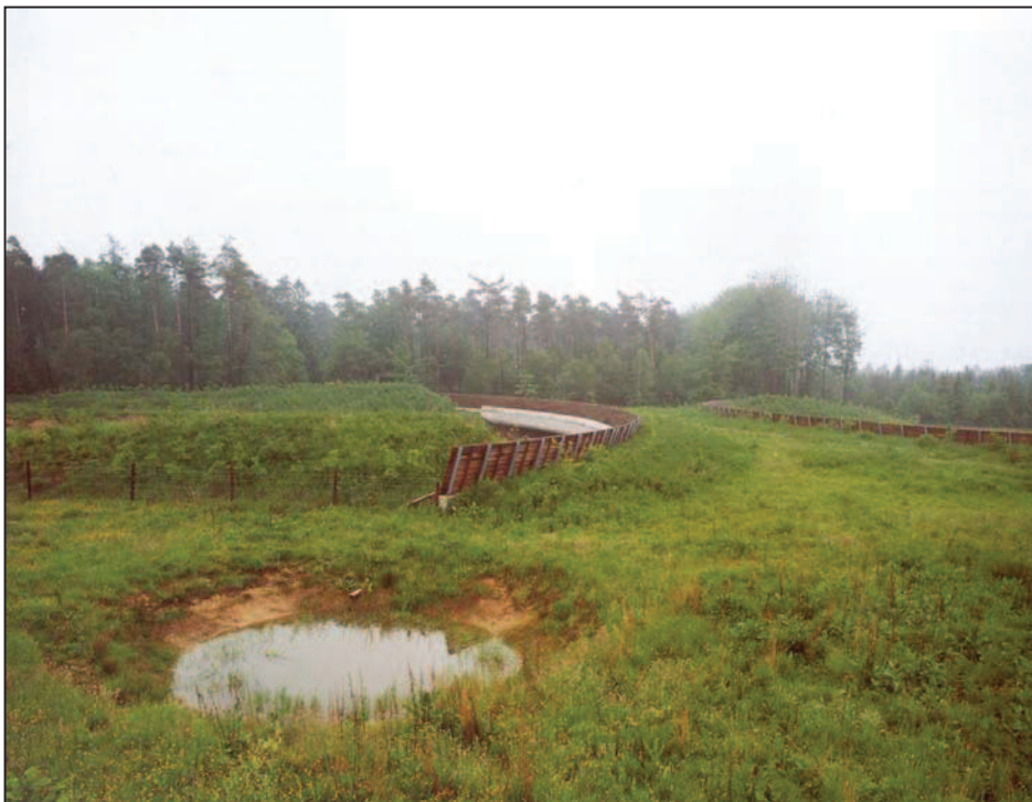
Abb. 7: Die gleiche Grünbrücke von oben: Lehm Boden bedeckt die Brücke, an deren Eingang ein kleiner Tümpel für Amphibien angelegt wurde. An den Seiten schirmen Holzpaneele die Brücke gegen Lärm und Licht von der Straße ab. Einen zusätzlichen Schirm sollen später die beidseitig angepflanzten Gehölze bieten, die aber zur Zeit der Aufnahme noch klein waren. Die Passage wird regelmäßig von Großsäugern, z.B. Rehen und Dachsen benutzt.
