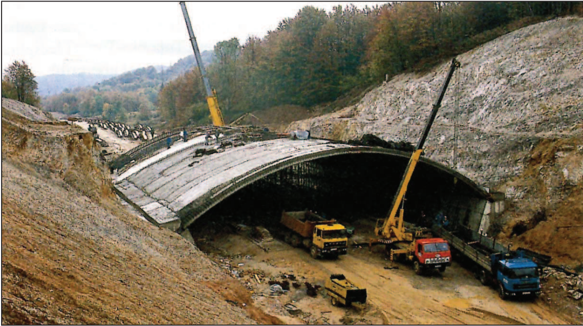
Abb. 8: Grünbrücke im Bau an der Autobahn Korlovac-Rijeka. Der Autobahnneubau durchschneidet einen wichtigen Korridor für Großraubtiere, u.a. für Braunbären. Die Kosten für die hundert Meter breite Grünbrücke beliefen sich auf rund 2,5 Mio. €.
