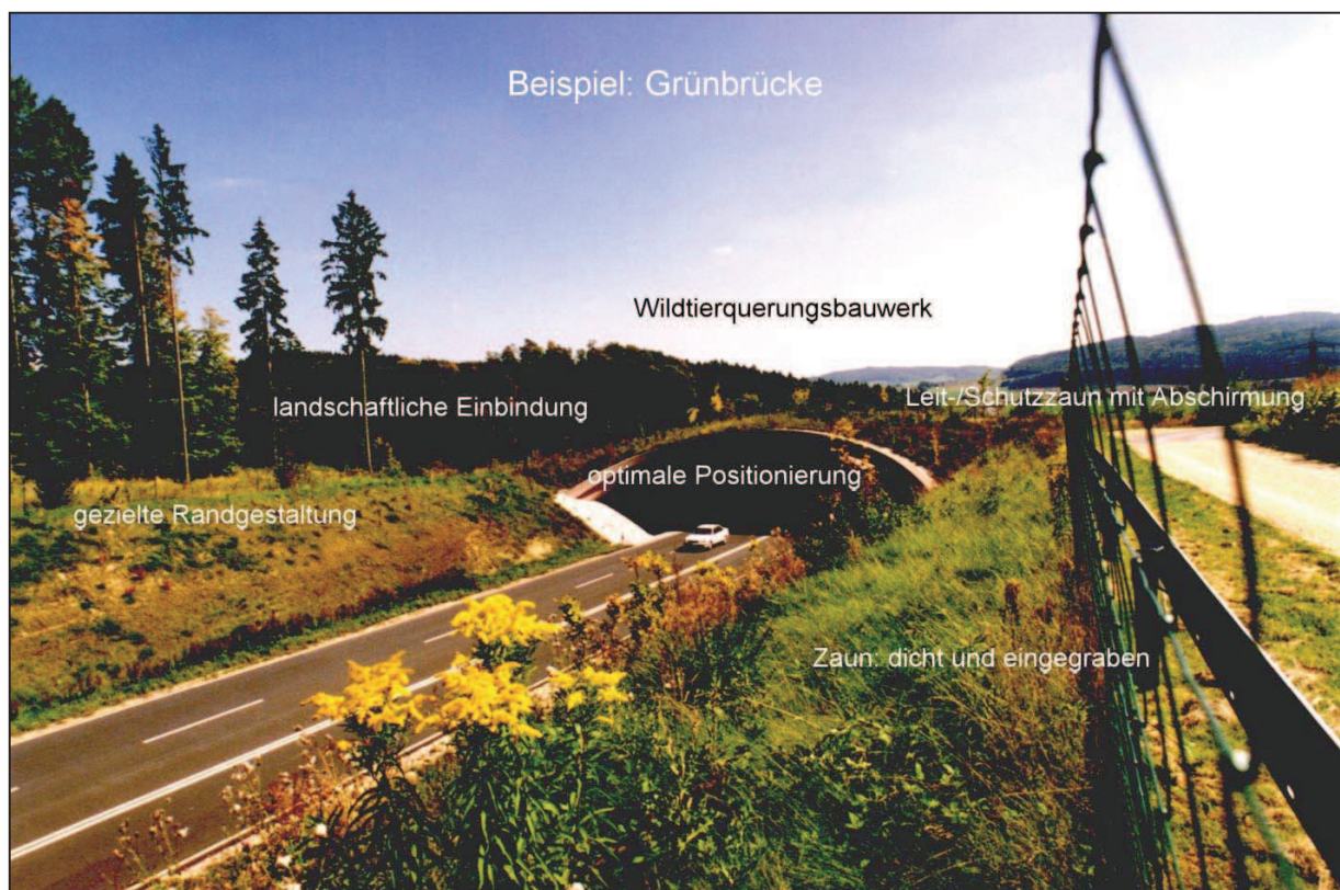
Abb. 4: Beispiel für die richtige Gestaltung eines Querungsbauwerks mit den entsprechenden Leitstrukturen.
