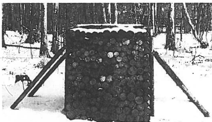
Reiserstangen-Schirm (dreiteilig) am Waldrand. Maße der Seitenwände: Höhe 1,80 m, obere Breite 50 cm, untere 1,50 m. Vordere Wand 1,80×2,00 m. Sichtöffnung 30 cm breit. Materialaufwand: etwa 100 laufende Meter Reiserstangen, 3–5 cm Ø zum Verblenden, 4 Rahmenhölzer à 1,80 m und 2 à 2,10 m, bei 6–8 cm Ø. Kosten trotz 150 Nägeln nur etwa 25 DM. Arbeitsaufwand gut 4–5 Std.
