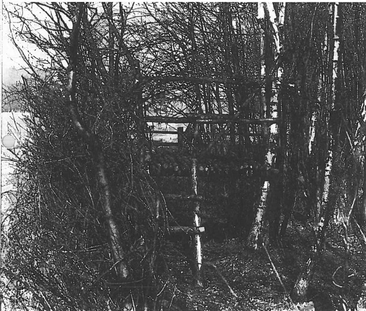
Hochgestellter Schirm aus dünnen Fichtenstangen hinter einer „Baumhecke“. Die Konturen des teils unverblendeten Schirmes verlieren sich zwischen den engstehenden Stämmen. Maße: Bodenhöhe 1,50 m, Bodenfläche 1,35x1,60 m. Materialbedarf: 4 Auflagehölzer à 1,60 m, 7-8 cm Ø; 2 Eckpfähle à 2,50 m; 2 Leiterholme à 1,50 cm; 20 Bodenhölzer à 1,60 m, 5-6 cm Ø. Für Rahmen, Sitz, Leitersprossen rund 25 laufende Meter Stangen. Materialkosten einschließlich 80 Nägel 20 DM. Bauzeit: etwa 3 Std.
