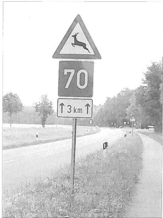
Abb. 3: Maßnahmen an der K 35 Ahaus-Gescher; Kreis Borken. Die Kombination von Warnschild und Richtgeschwindigkeit soll den Autofahrer zu erhöhter Aufmerksamkeit und angepasster Geschwindigkeit veranlassen. Die Leitpfosten wurden im Abstand von 25 m montiert und mit Wildwarnreflektoren versehen.
