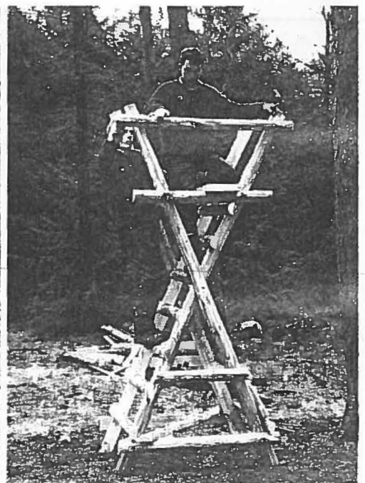
Befestigung der oberen Kranzteile
