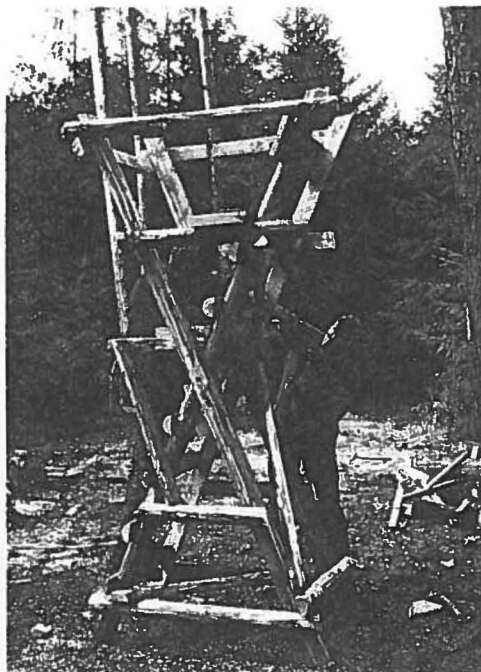
Zur Stabilisierung werden an der Rückseite Diagonale angebracht
