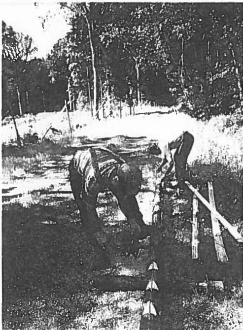
Nach dem Auftrennen der Holme werden die Kerben für die Leitersprossen eingesägt
