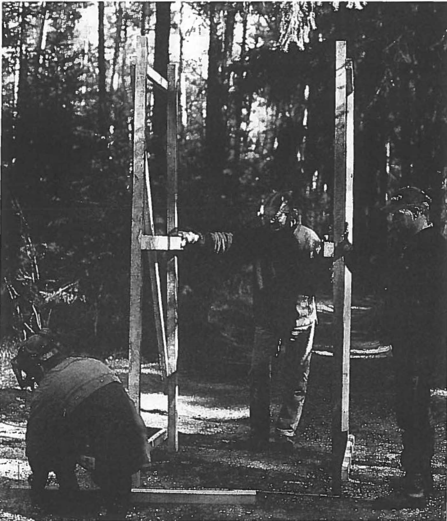
Die Seitenteile werden parallel zueinander aufgestellt. Das folgende Anbringen des Boden- und Fußbodenkranzes sind die einzigen Fertigungsschritte, zu denen die Unterstützung von mindestens einer weiteren Person notwendig ist
