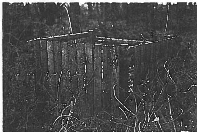
Abb. 2/3: Ein zerlegbarer Erdsitz mit einer Verkleidung aus Fichtenbrettern. Die Querriegel sind so angebracht, daß sich die Wände mit langen Nägeln zusammensetzen lassen (r.).
