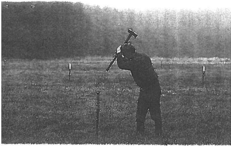
Jeder Teichbau beginnt mit der Festlegung der Umriss- lagen von Pfählen hat sich bewährt
