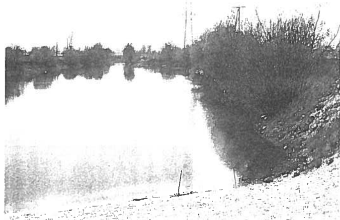
Wenn bei der Kiesentnahme nicht von Anfang an auf die Ausbildung einer Flachwasserzone geachtet wird, entstehen steile Uferböschungen ohne jeglichen Schilfbewuchs.
